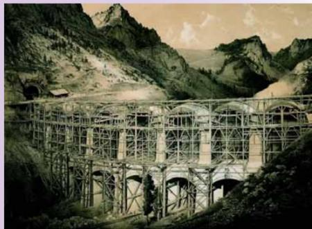
Abb. 82.2: Bau eines Viaduktes. Die Semmeringbahn war die erste vollspurige Bergbahn Europas. 1998 wurde die Semmeringbahn von der UNESCO zum Weltkulturerbe erklärt.
